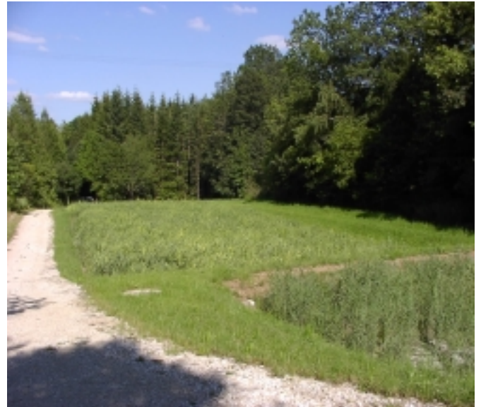
Juli 2004 – Im Vordergrund die Klärschlammvererdungsanlage
