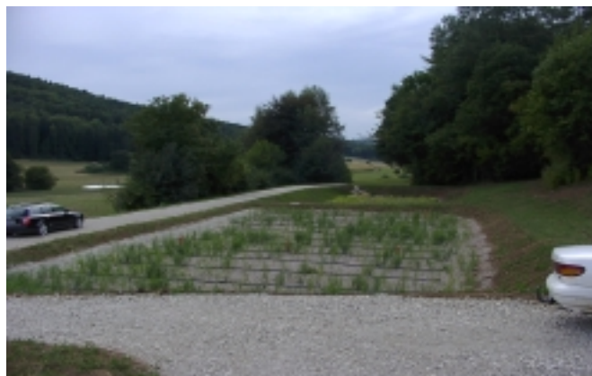
Pflanzenkläranlage kurz nach Inbetriebnahme – Juli 2003
