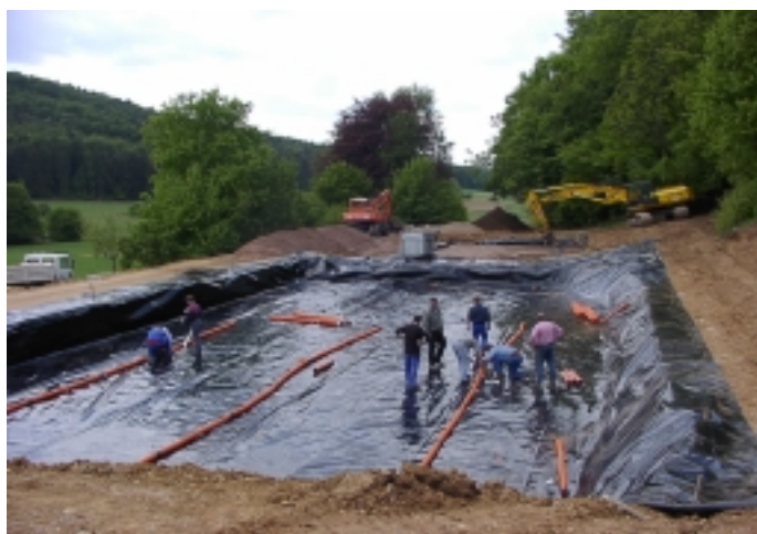
Verlegen der Sohlrännagen - Eigenleistung
